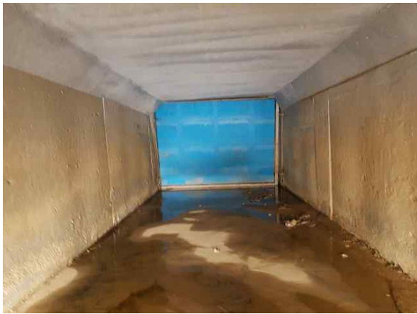
BOX내부 1런 보수현황
