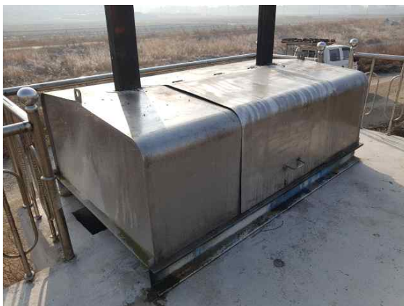
권양기 상태 양호
