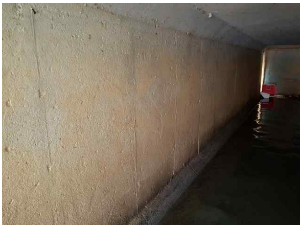
내부 벽체 현황(양호)
