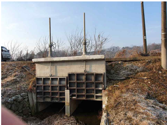
권양기 상태 양호
